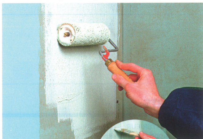
Zweite Schicht CERMICRYL
