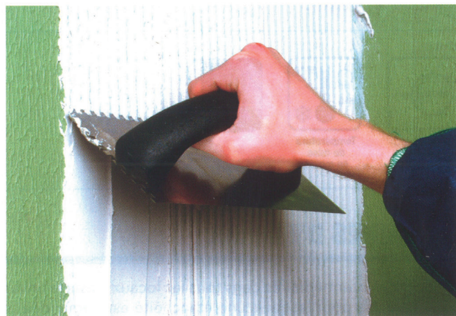
Auftragen des CERMIPLUS oder CERMIFIX
