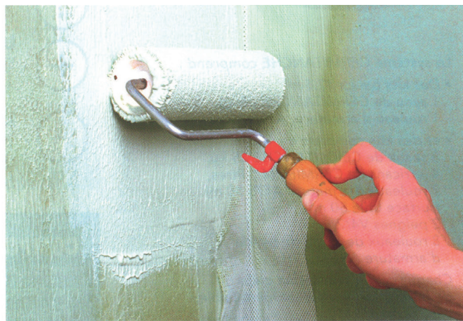
Erste Schicht CERMICRYL
